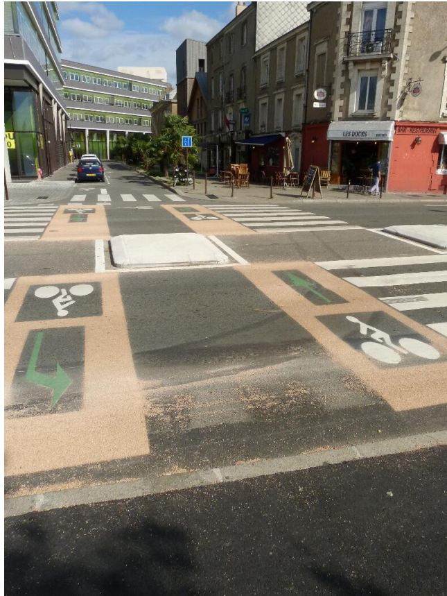
Côté Sud du pont Anne de Bretagne à Nantes
