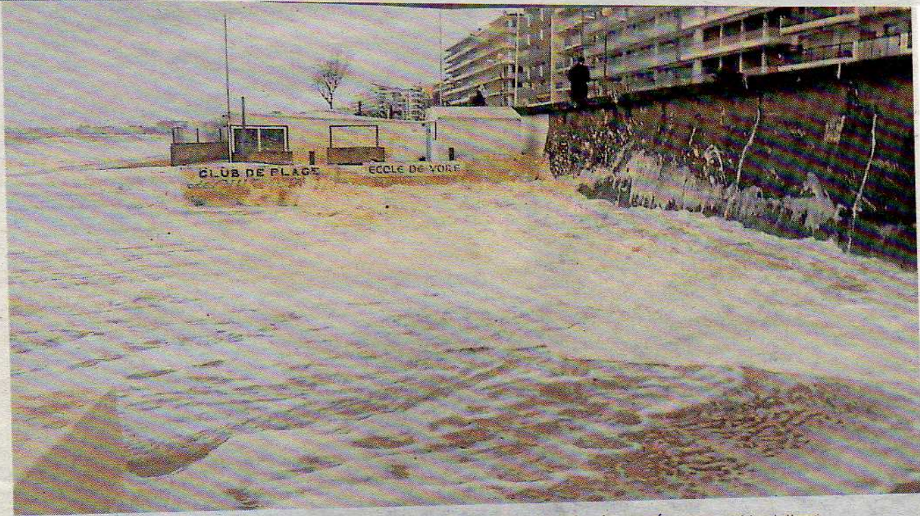
La Baule, le 1 er janvier : l'eau est brusquement montée et les structures de plage ont été endommagées. Photo PO-Stéphane Le Hesran
